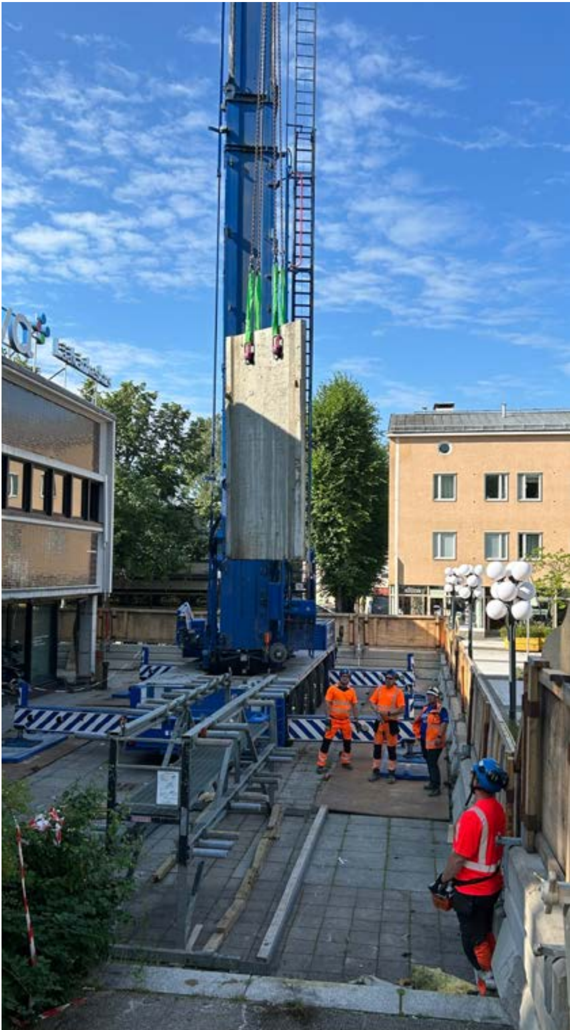
Demolition site Kiinteistö Oy Keravan Kauppakaari 1
