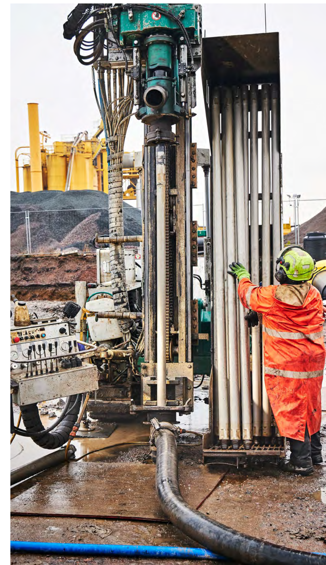
Maalämmön asentamista K0y Tuusulan Högbergintie 5:ssä
