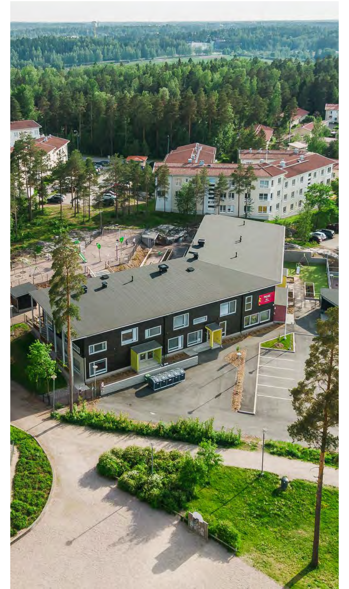
Lintukorpi 16, Espoo, hirsirunkoinen päiväkotikiinteistö
