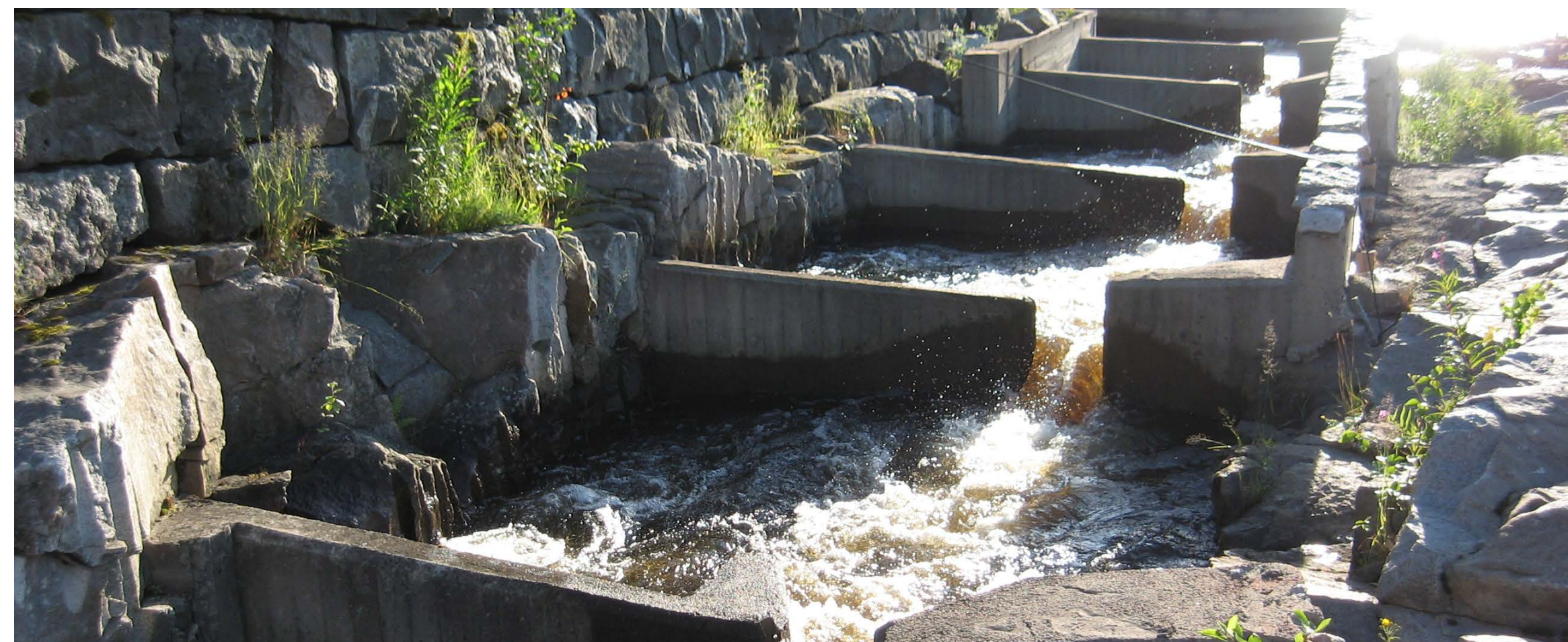
Kalaportaita Oomin Merikosken vesisähkövoimalasta
